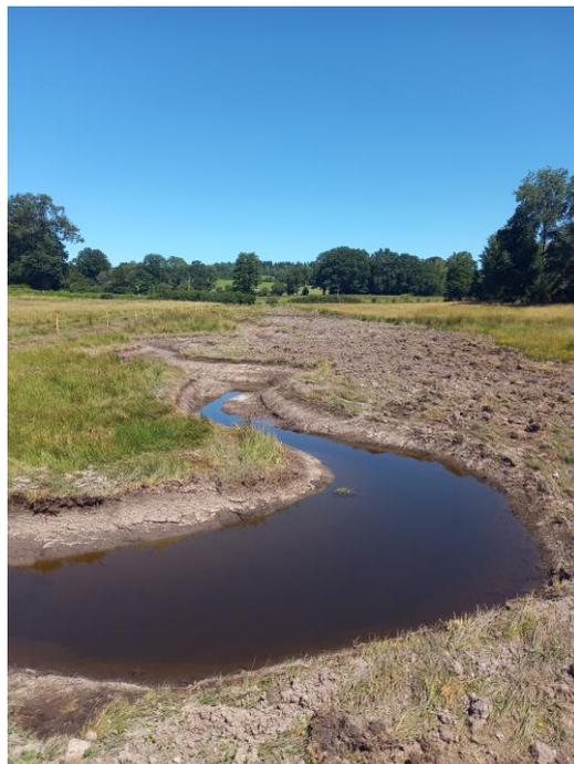
Figure 19 : Remise en thalweg avec reméandrage (photo prise directement à la fin du chantier)
