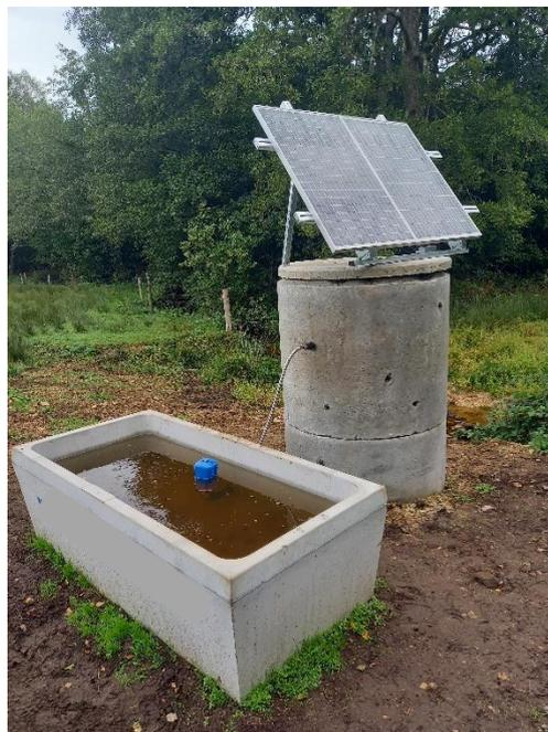
Figure 15 : Bac d'abreuvement avec pompage solaire
