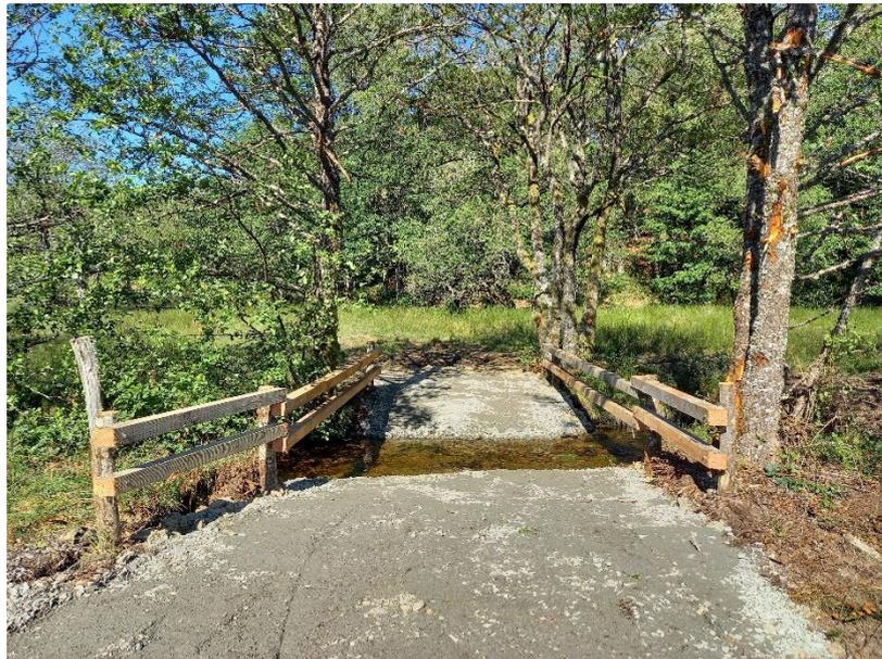
Figure 11 : Exemple de passage à gué
